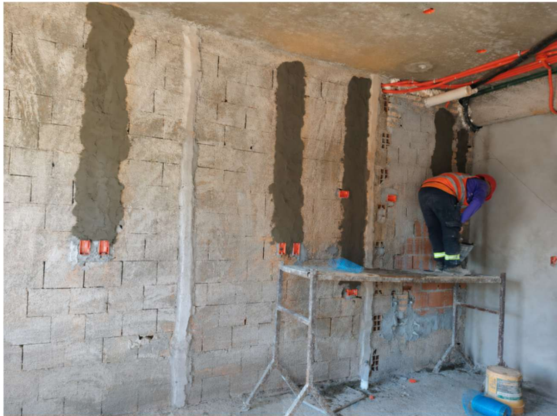
Faja para revoque en departamentos – Trabajos de PCI en pasillos
