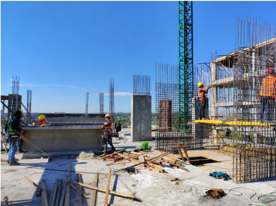
Trabajos de armadura de pilares y muros – Vista lateral de la obra
