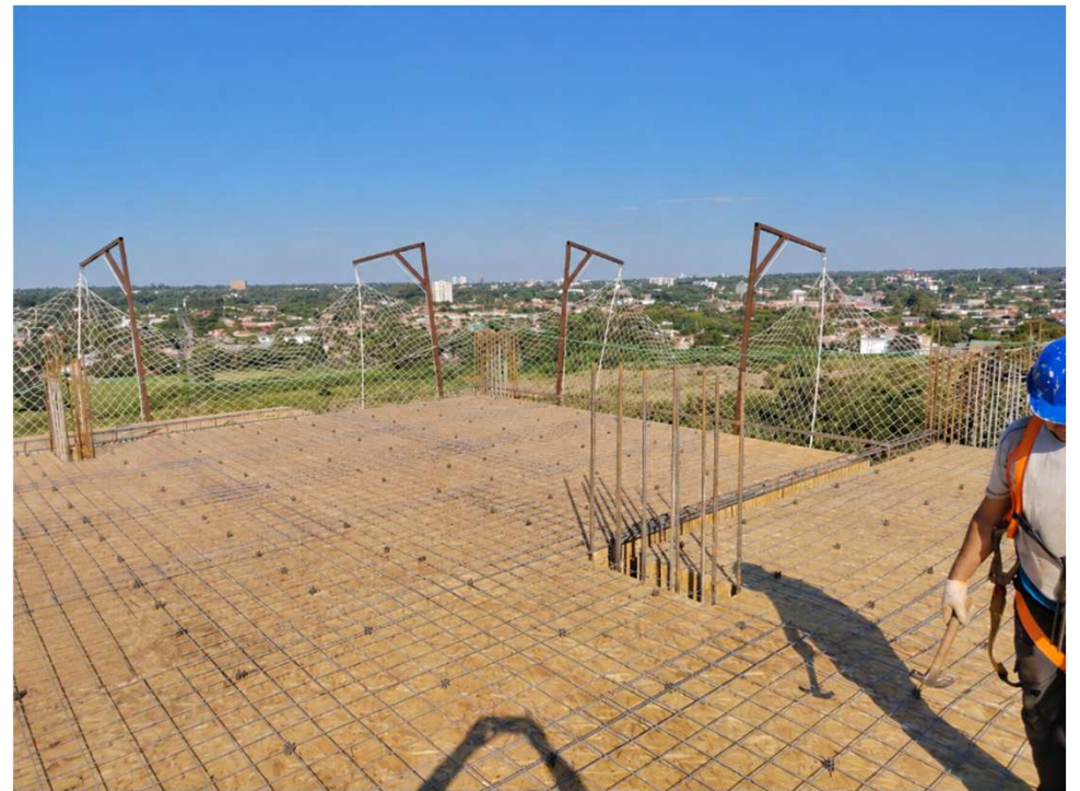
Trabajos de encofrado y armadura de losa
